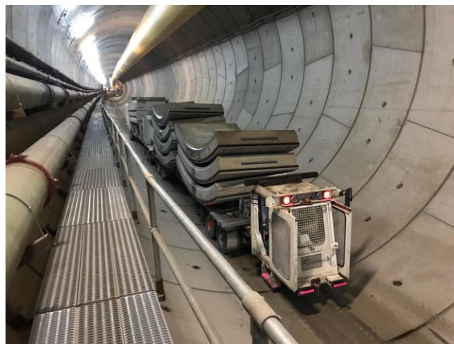
Le TSP 70 tonnes transportant des voussoirs
