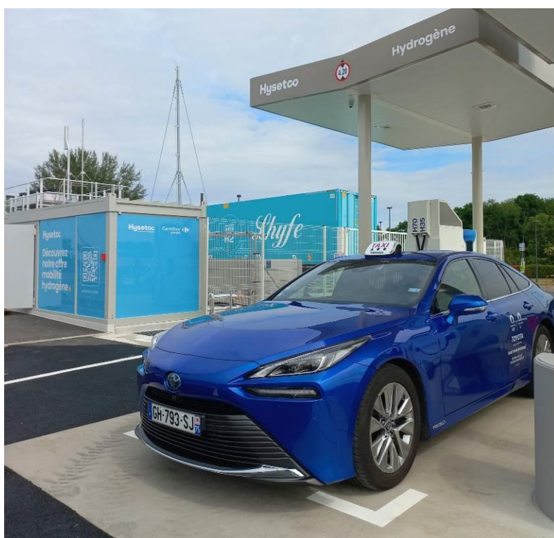
Légende : station hydrogène du réseau HysetCo, à Collégien (77), alimentée par l'hydrogène vert et renouvelable de Lhyfe (conteneur en arrière-plan). Visuel HD sur ce lien . Crédit : HysetCo et Lhyfe.
