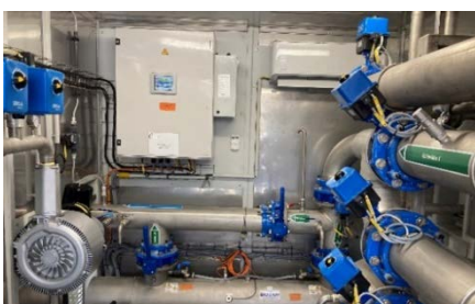
Réacteur BIO-UV Group intégré dans la REUT BOX VEOLIA
