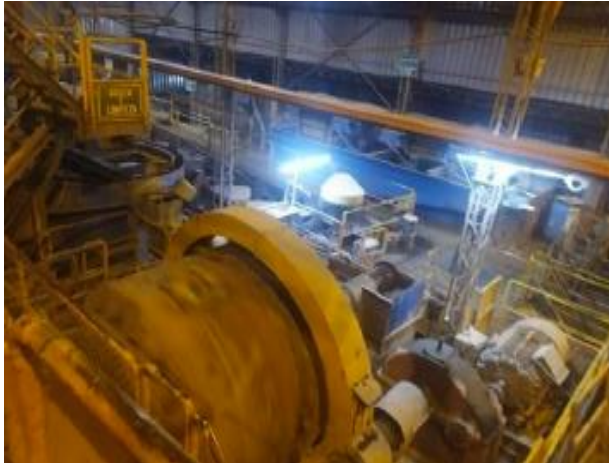
Ligne de production – Usine Ana María
