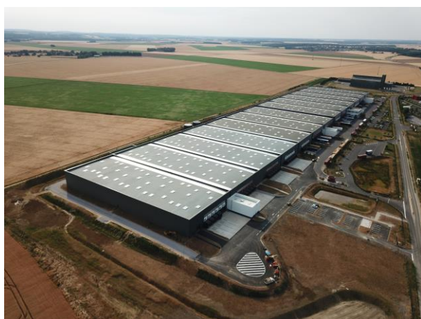
Vue aérienne du site logistique d'Amblainville
